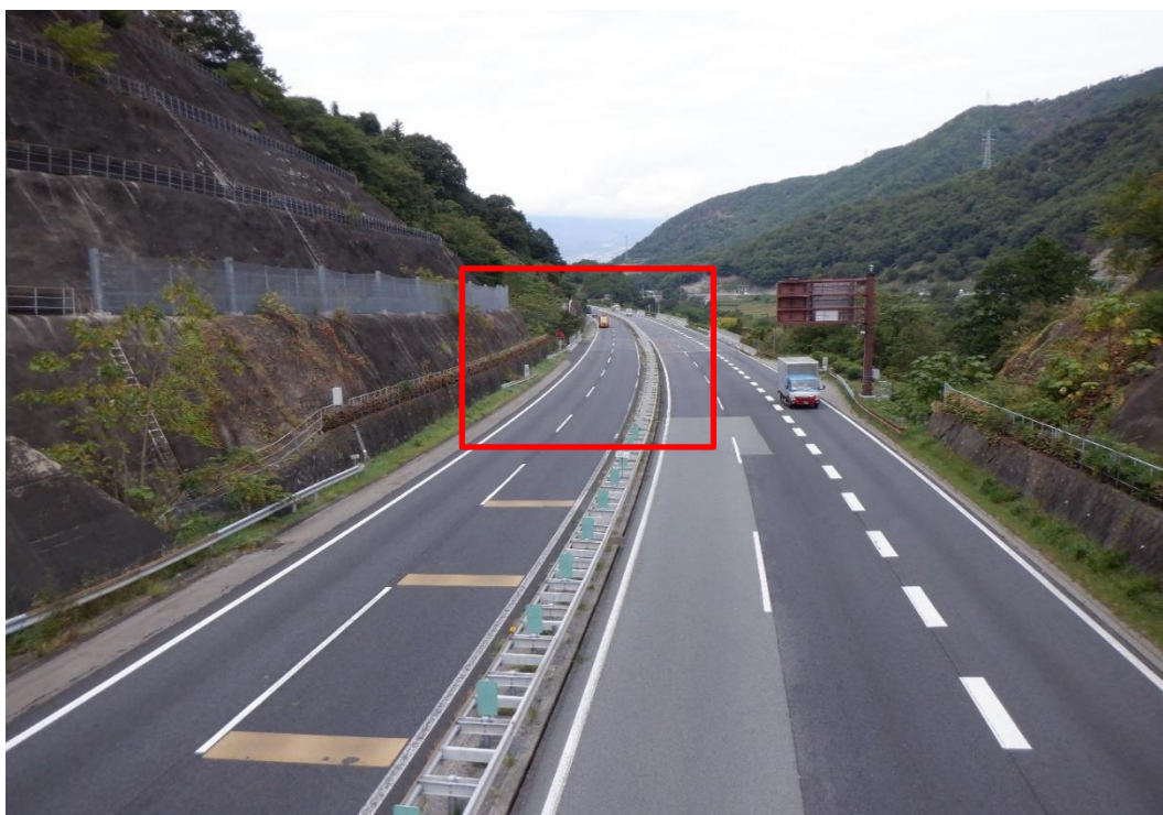
写真５－１ 事故地点（屋間の状況（令和３年１０月７日撮影））
