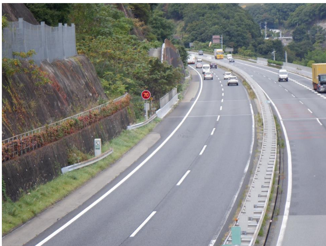
写真５－２ 事故地点近景（屋間の状況（写真５－１赤枠部））
